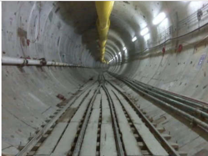
Figura 2. Cambio de vía del tren de servicio dentro del túnel
