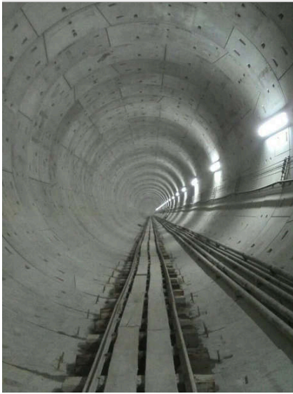
Figura 1. Túnel revestido con vías para el tren de servicio y líneas de servicio
