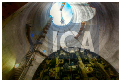
Figura 13. Vista hacia arriba desde el fondo de una lumbrera con la cabeza de la tuneladora
