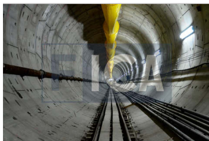
Figura 19. Túnel revestido con vía del tren de servicio y ducto de ventilación
