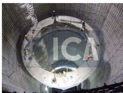
Figura 6. Fondo de lumbrera con la losa armada y personal trabajando
