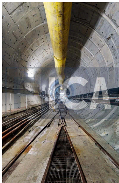
Figura 21. Tramo de túnel con vías y ducto de ventilación en la clave
