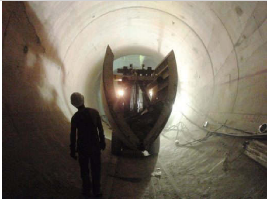
Figura 17.20. Cimbra telescópica y jumbo durante el revestimiento definitivo
