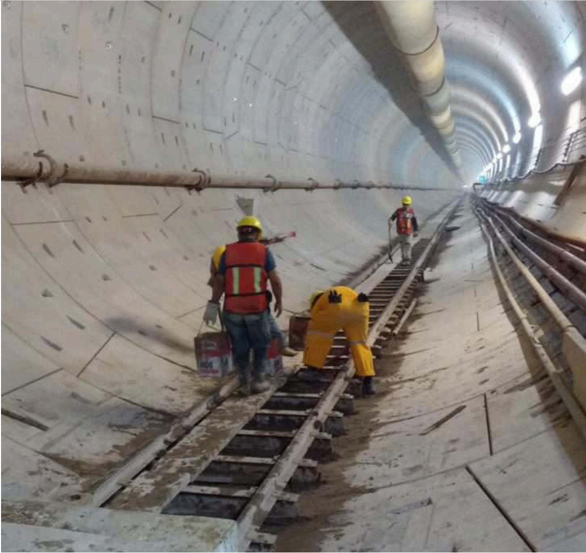
Figura 20.10. Trabajos en las vías de la locomotora del tren de apoyo
