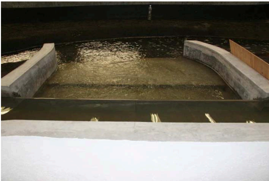
Figura 17.12. Detalle del vertedor de excedencias del TEO en el modelo físico
