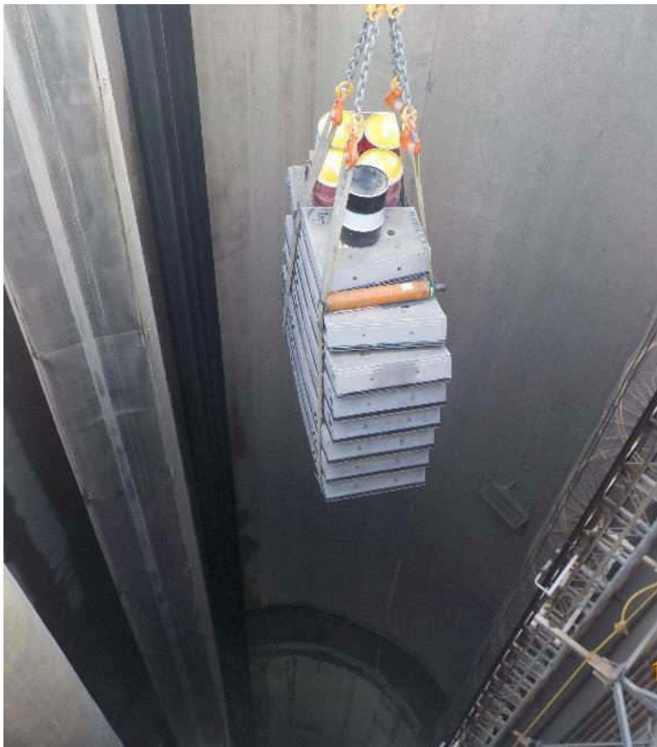
Figura 14.29. Descenso de dovelas al fondo de la lumbrera con la grúa pórtico
