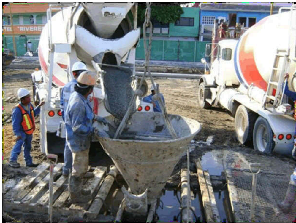
Figura 15.31. Colado del tablero con cuchara de concreto
