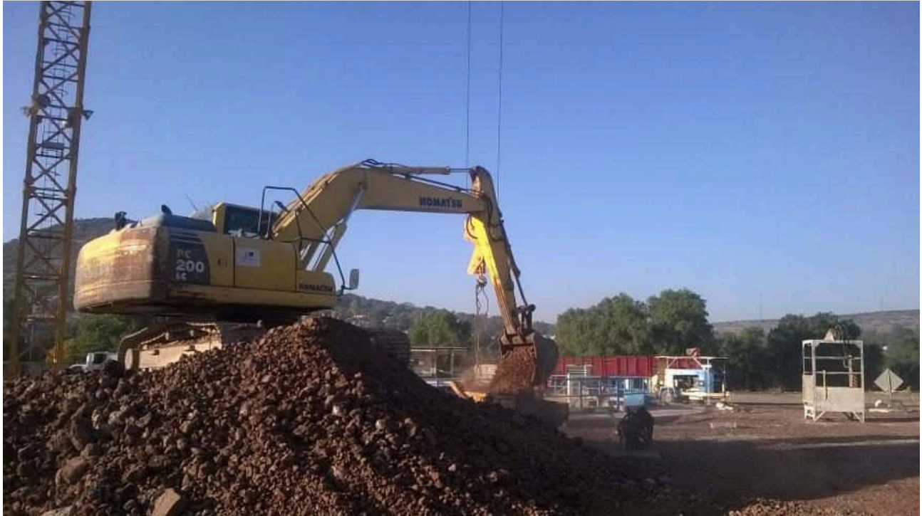
Figura 14.37. Relleno compactado del fondo de la lumbrera antes de la media sección
