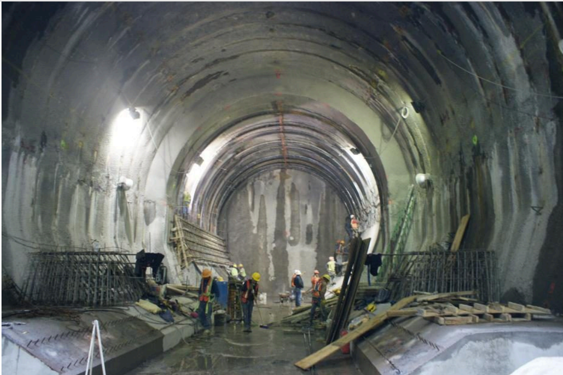
Figura 14.35. Galería de montaje en construcción con marcos metálicos y concreto lanzado
