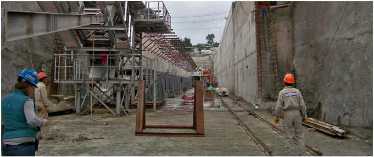
Figura 15.28. Portal de salida del TEO en construcción
