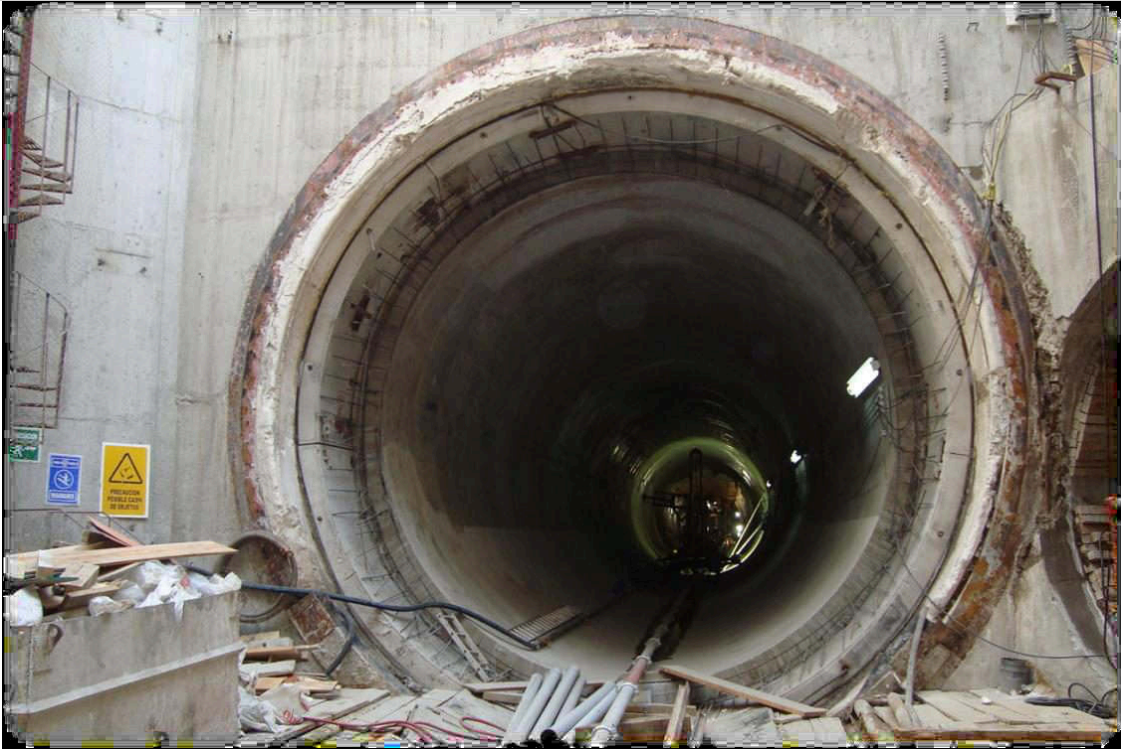
Figura 15.40. Acceso revestido del túnel en la luminera 0
