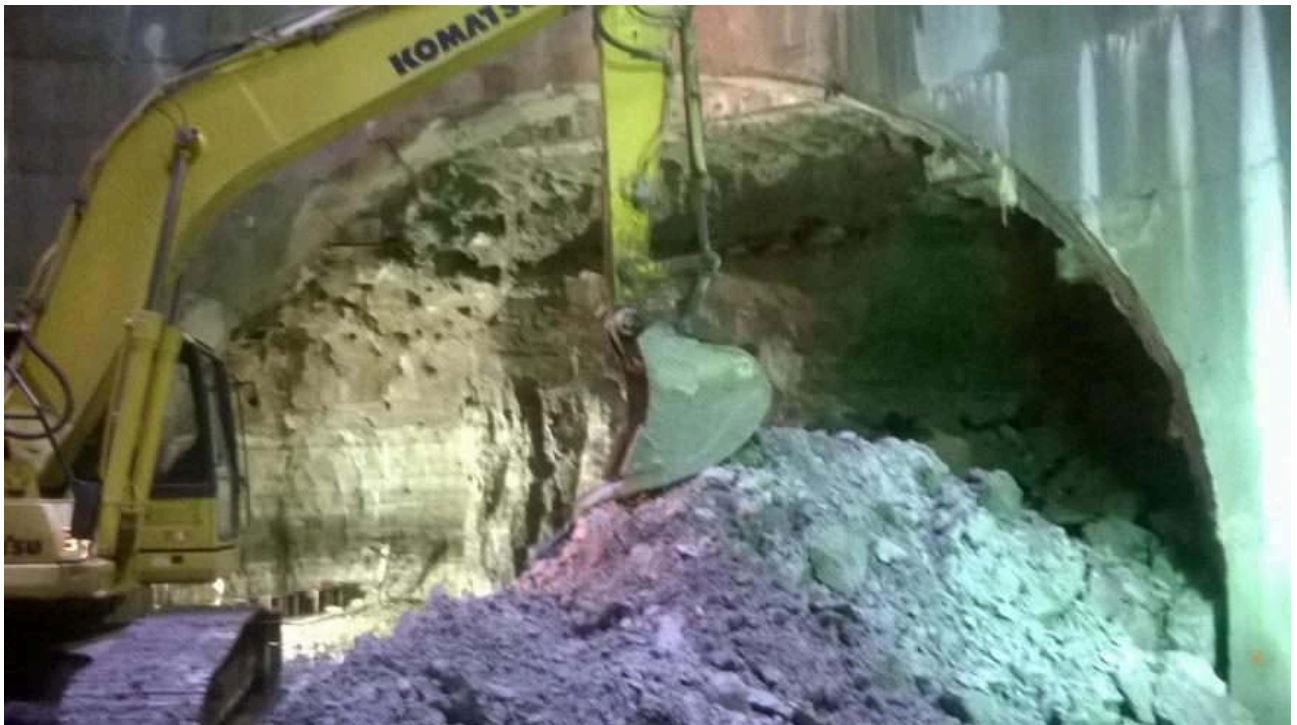
Figura 14.44. Excavación de la media sección superior
