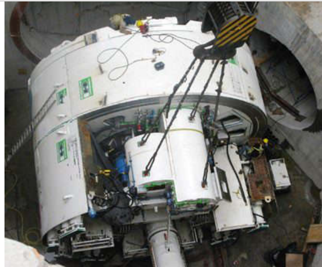
Figura 14.14. Descenso de la tuneladora HK497 al fondo de la lumbrera O
