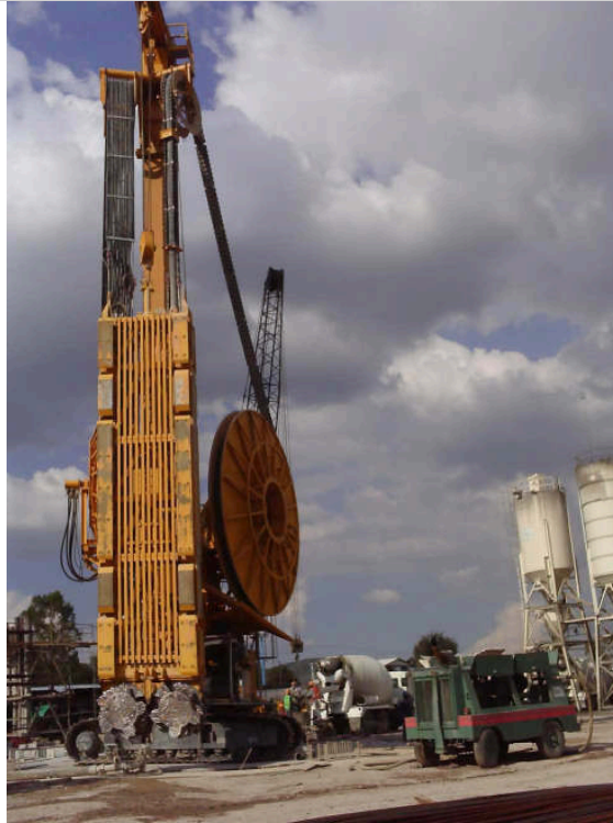
Figura 14.21. Hidrofresa trabajando en la lumbrera L-19
