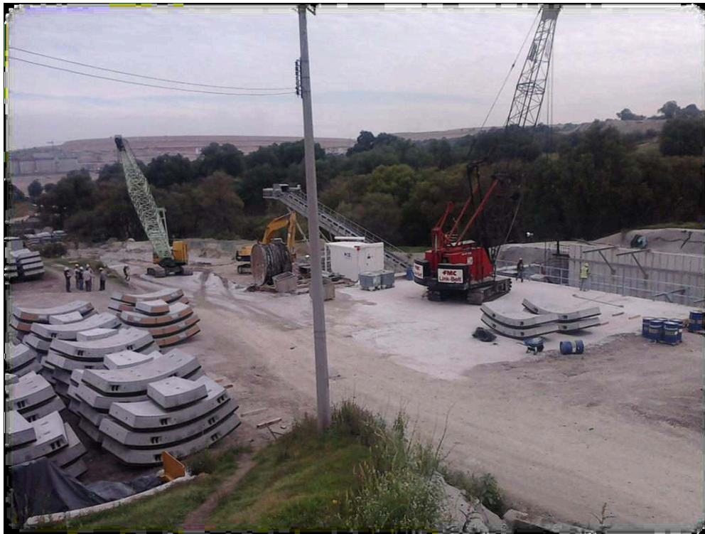
Figura 15.41. Losa base y patio de dovelas para el descenso del equipo
