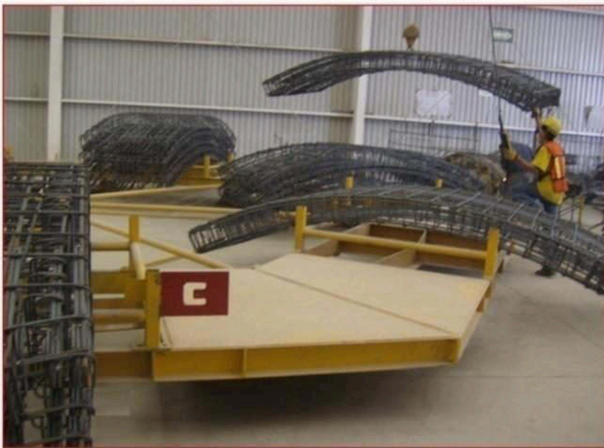
Figura 16.4. Armaduras curvas de dovelas junto a la mesa giratoria de armado
