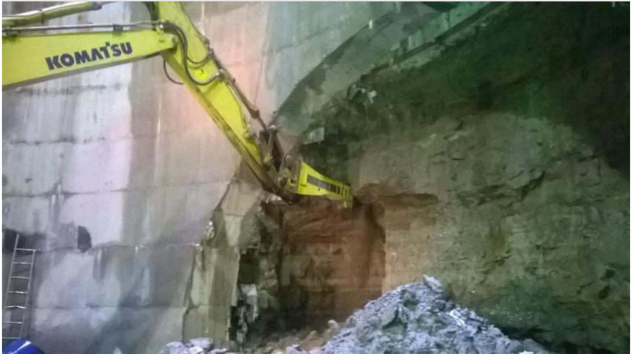
Figura 14.39. Demolición del revestimiento primario de la lumbrera para abrir la galería
