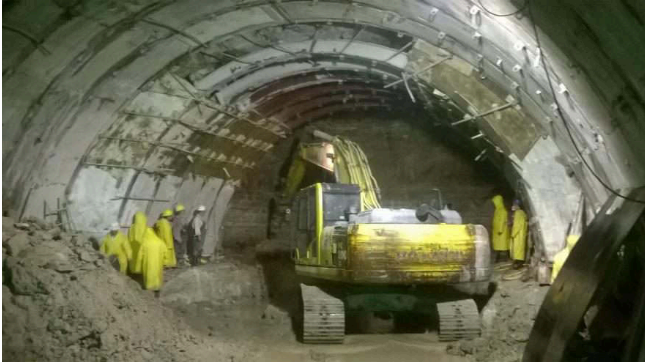
Figura 14.47. Etapas subsecuentes de excavación y revestimiento
