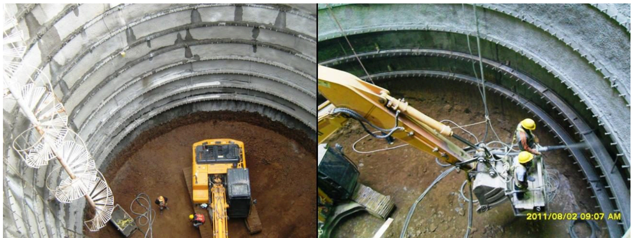
Figura 15.43. Lumbrera con concreto lanzado, marcos metálicos y excavación con retroexcavadora
