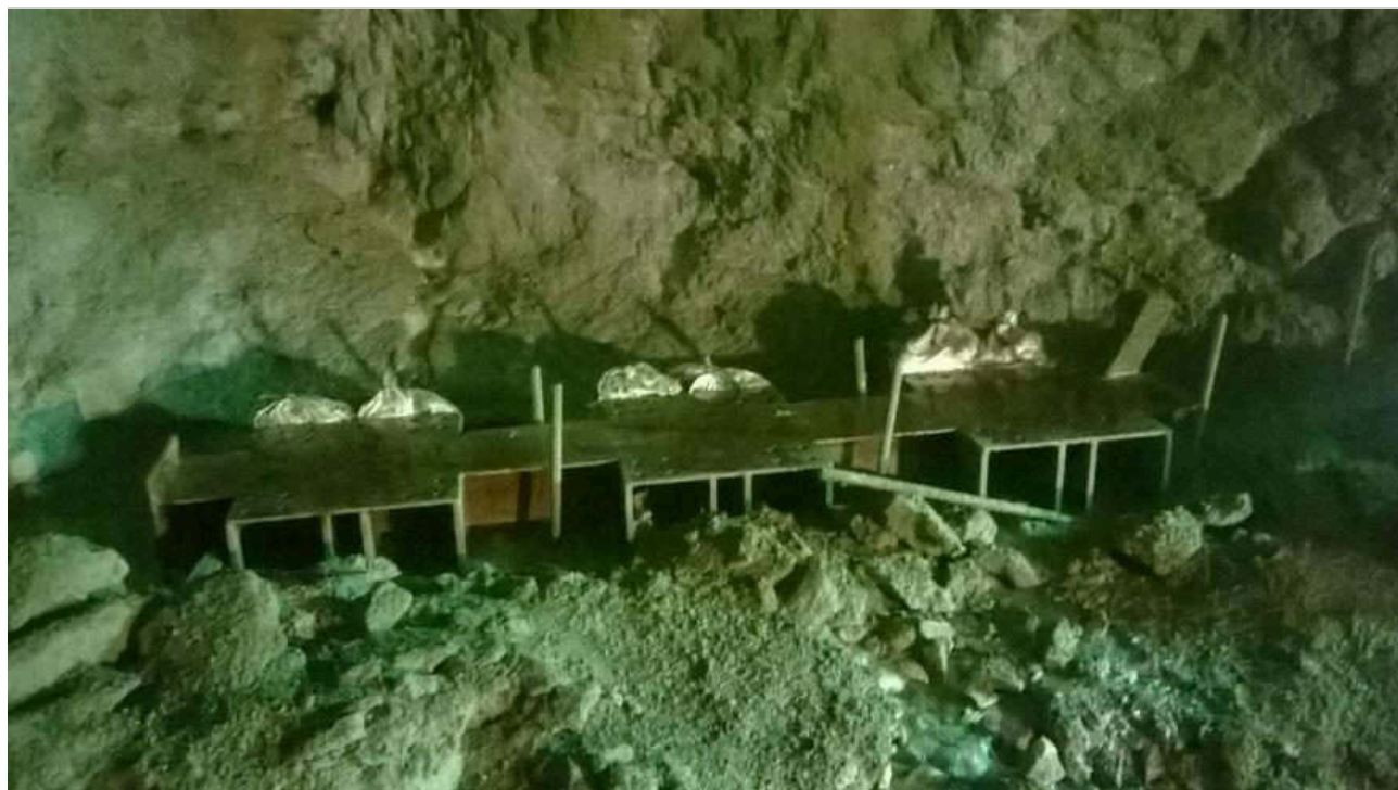
Figura 14.41. Vigas rastra en las coyoterías
