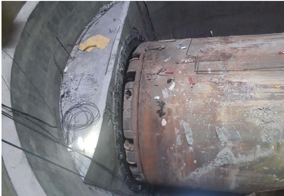
Figura 14.105. Tuneladora Hidalgo antes de ingresar al portal de la lumbrera
