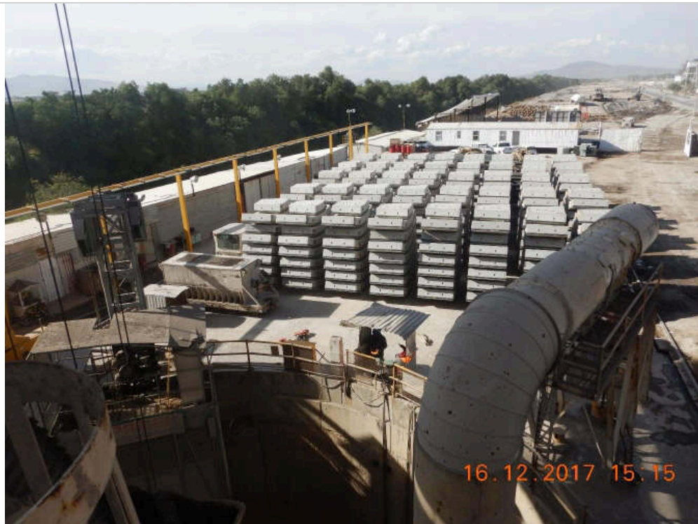
Figura 14.25. Patio de almacenamiento de dovelas en la lumbrera
