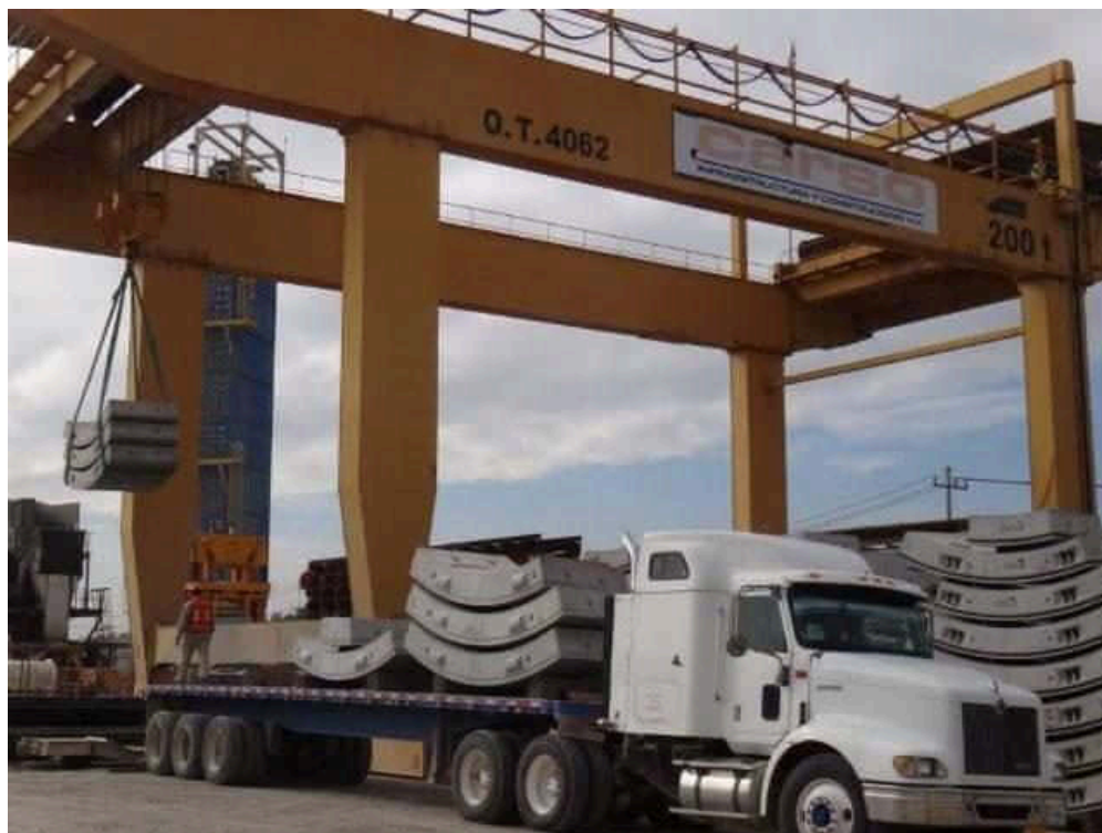
Figura 14.26. Descarga de una plataforma de dovelas con la grúa pórtico
