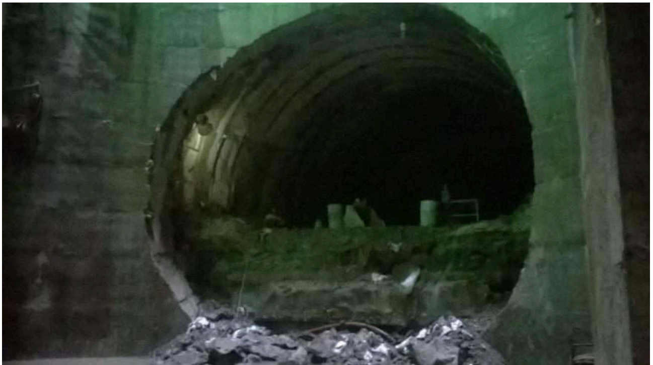
Figura 14.48. Demolición del revestimiento primario de la media sección inferior
