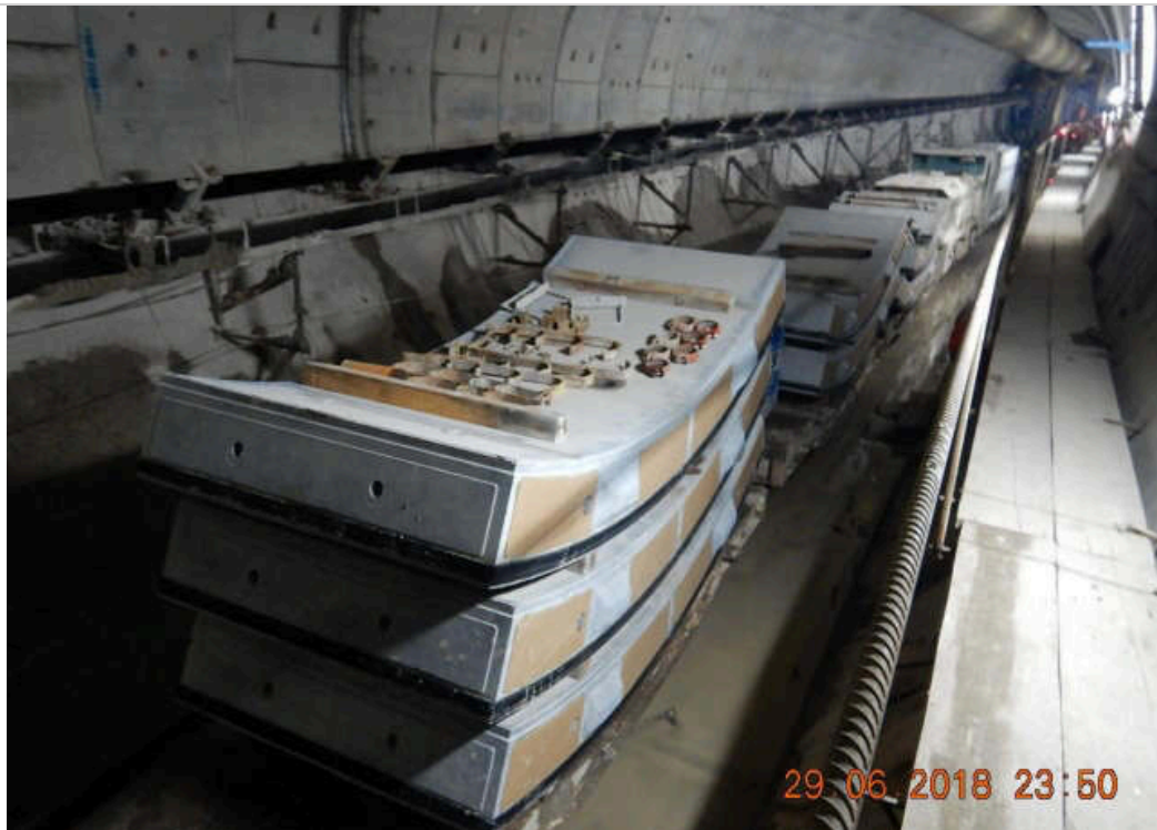
Figura 14.30. Carros doveleros con dovelas en el fondo de lumbrera
