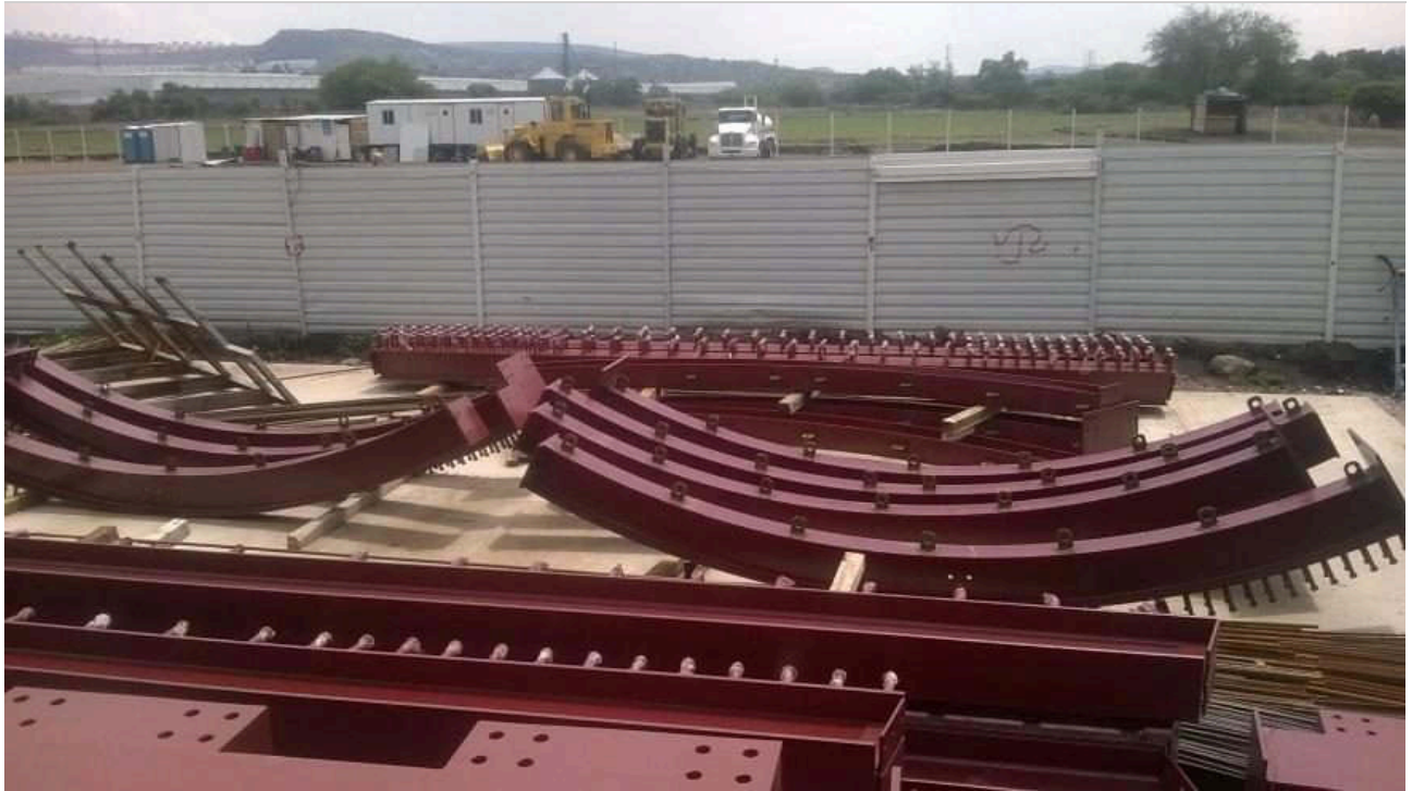
Figura 14.43. Almacén de marcos metálicos
