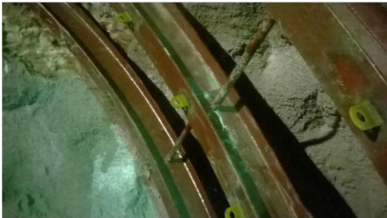
Figura 14.45. Tensores entre marcos metálicos
