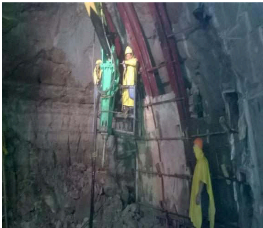
Figura 14.46. Lanzado de concreto entre marcos
