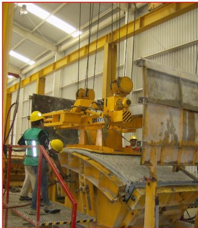
Figura 16.6. Desmolde de una dovela con grúa de ventosa
