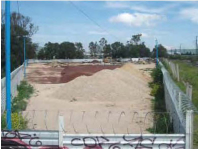
Figura 15.14. Mejoramiento del suelo en el predio de la L-18
