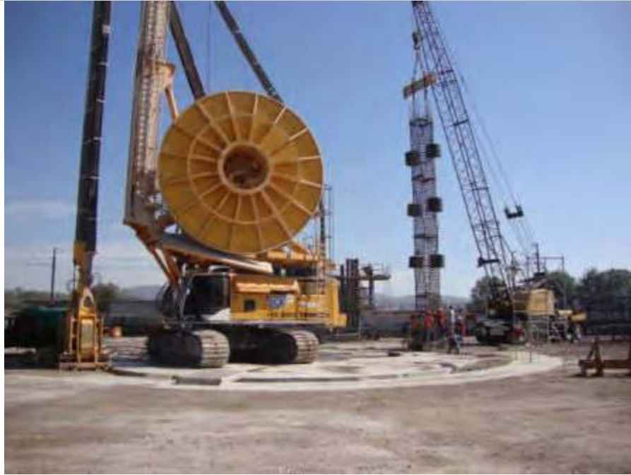
Figura 15.18. Hidrofresa y armadura en tableros opuestos de la L-18
