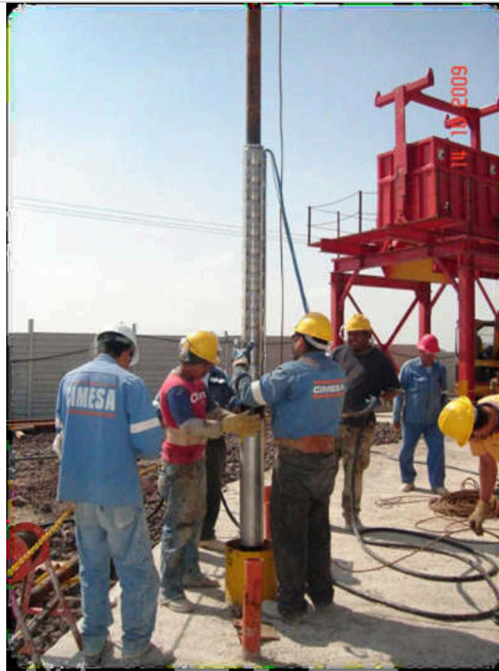
Figura 15.34. Colocación del sistema de bombeo
