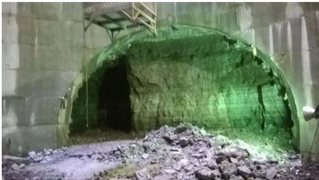
Figura 14.42. Excavación para el primer marco metálico
