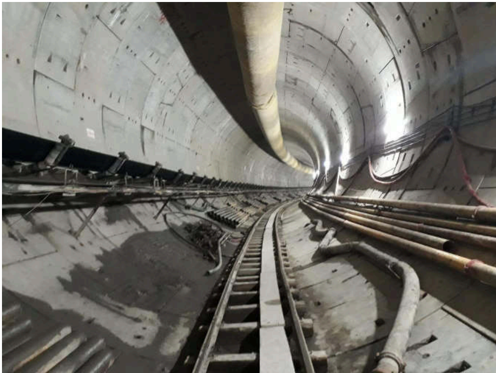
Figura 14.66. Instalaciones en el túnel durante la excavación
