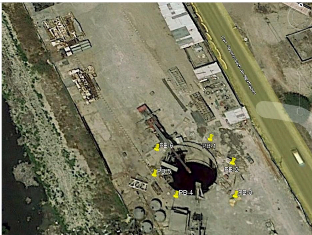
Figura 12.34. Seis pozos iniciales de abatimiento de la lumbrera L-12
