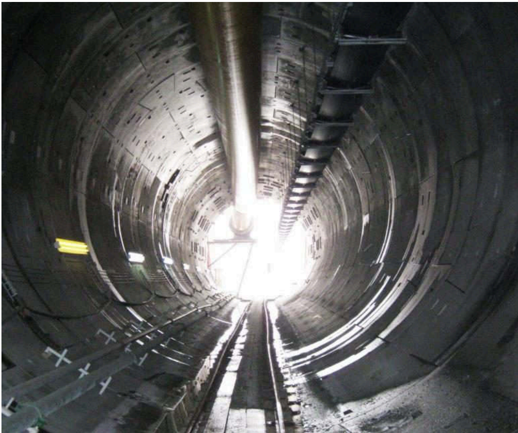
Figura 12.62. Interior del túnel con dovela y equipo de transporte
