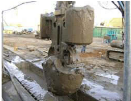
Figura 12.56. Almeja hidráulica en los tableros del muro Milán de la L-04
