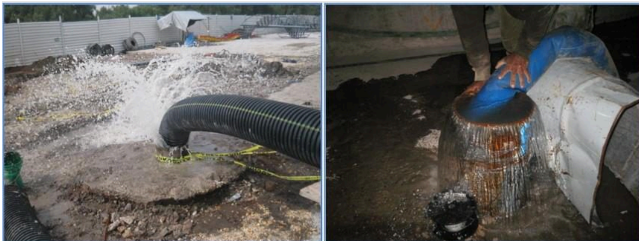
Figura 12.73. Descarga del agua extraída por el bombeo en la L-12
