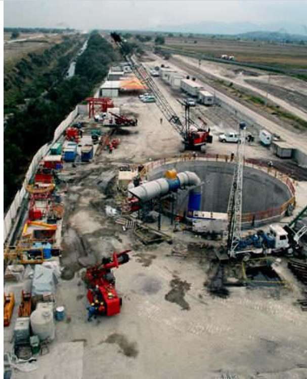
Figura 12.63. Lumbrera de servicio sobre el trazo del TEO vista desde el aire
