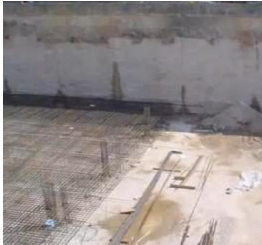
Figura 12.60. Armado de la losa de fondo de la L-04
