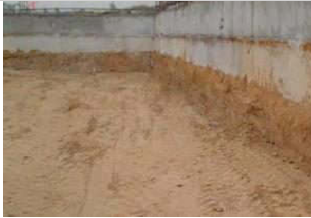
Figura 12.59. Excavación del núcleo dentro del muro Milán de la L-04
