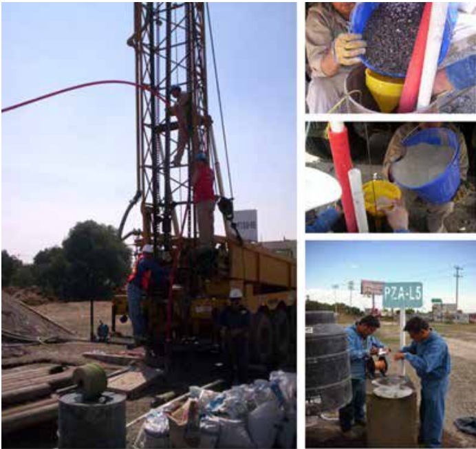
Figura 11.21. Instalación de un piezómetro abierto y primera lectura en el sitio PZA-L5
