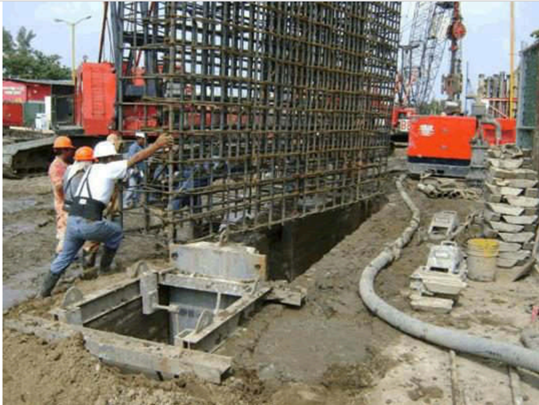
Figura 12.57. Armado de acero de un panel de la L-04
