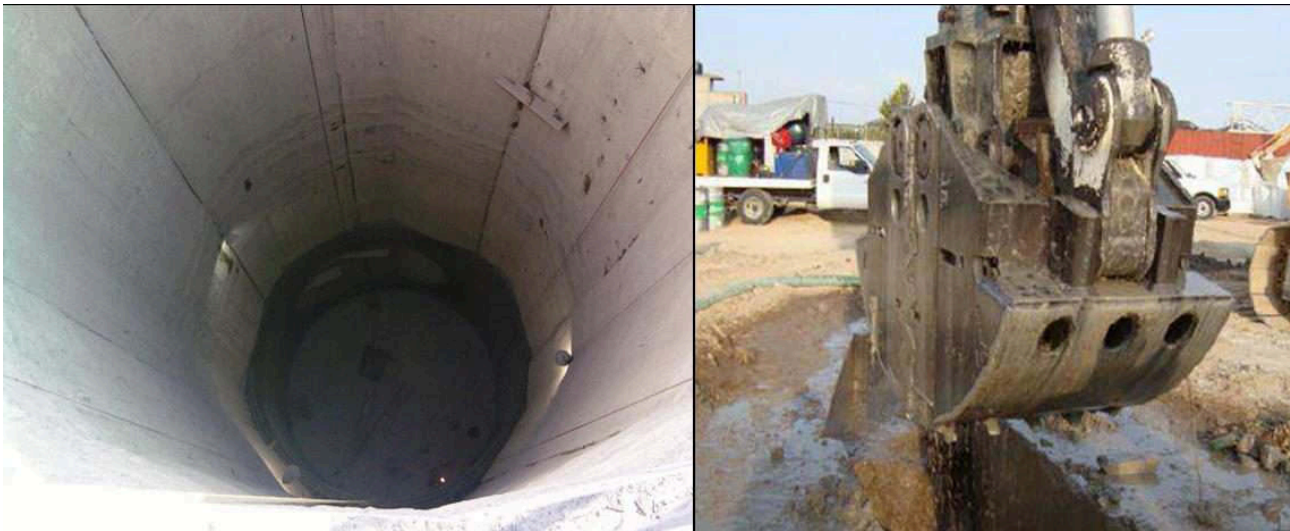
Figura 12.64. Lumbrera L-04 terminada y excavación de un tablero
