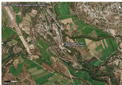
Figura 9.13. Portal de salida del TEO rodeado de parcelas de riego
