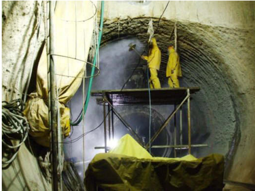
Figura 8.4. Inicio del hidroescarificado dentro del túnel del Emisor Central
