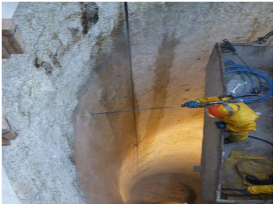
Figura 8.6. Hidroescarificado del muro de una lumbrera del Emisor Central
