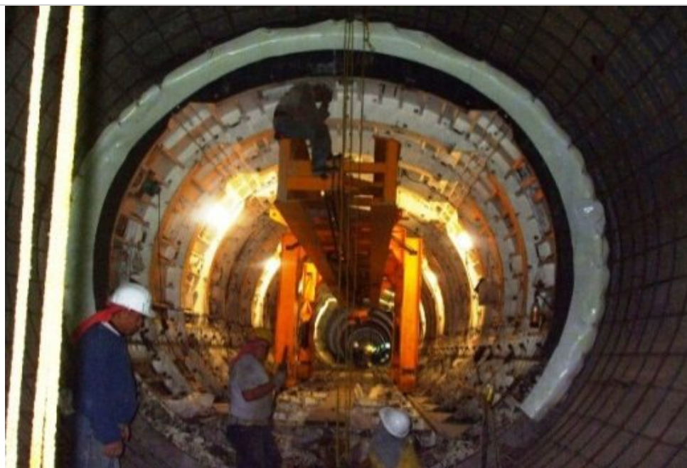
Figura 6.8. Colocación de la lámina T-Lock dentro de un túnel de drenaje con cimbra telescópica
